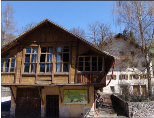
Der Gasthof Zellen, Villnößtal, wird abgerissen
